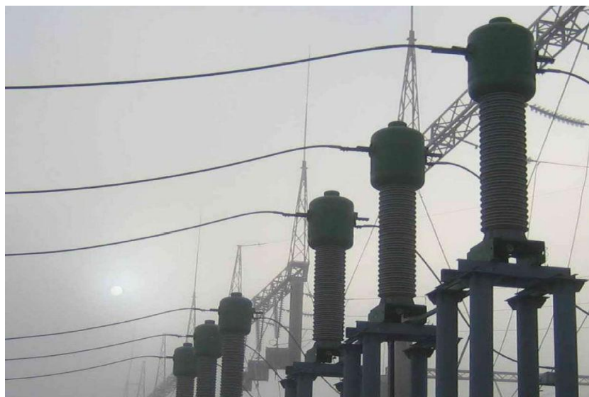
Рисунок 3.3 - Внешний вид трансформаторов тока ТГФМ-220У1
