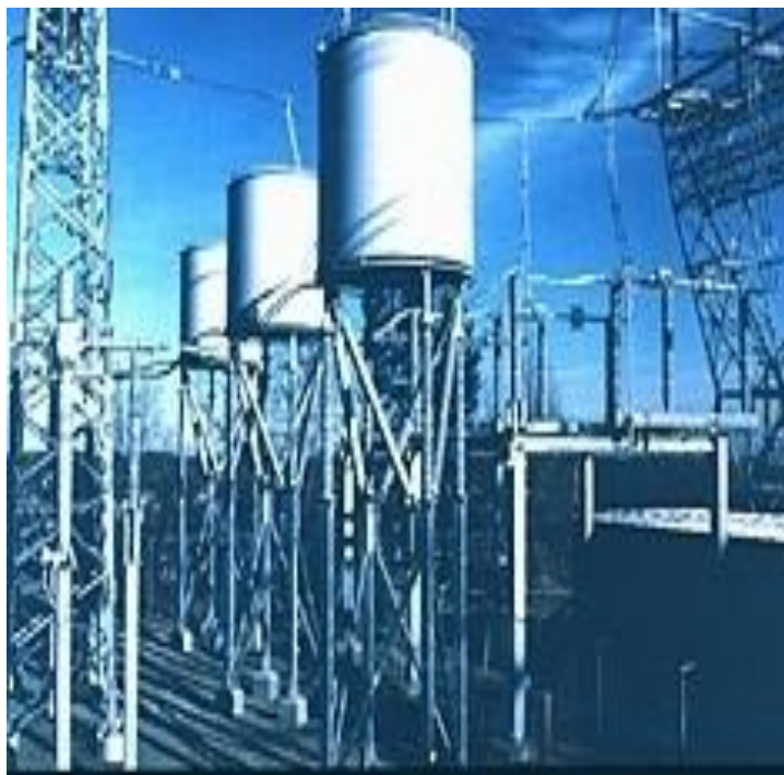
Рисунок 3.4 - Внешний вид реактора CLR – 1050/325/149.3
