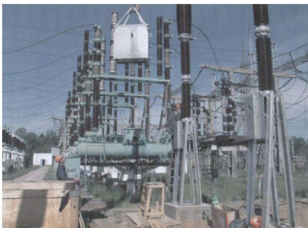
Рисунок 3.1 - Внешний вид элегазового выключателя GL314X
