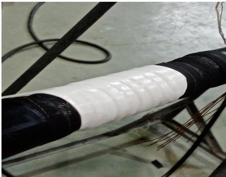
Рисунок 7 – Применение ленты АБРИС КИ–20 в качестве материала выравнивающего электрическое поле по гильзе
