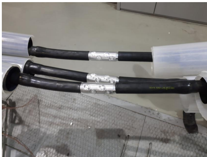
Рисунок 16 – Соединение жил кабеля болтовыми соединителями марки ГСП
