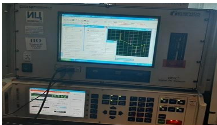
Рисунок 6 – Частичные разряды, возникающие на срезе экранирующего слоя показаны на измерителе ЧР DDX 8003 Результаты испытаний испытуемой кабельной сборки приведены в таблице 10.
