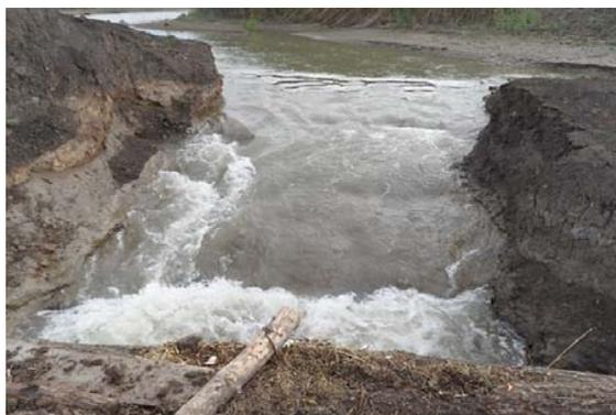
Рис. 5.23. Разрушение земляных плотин
