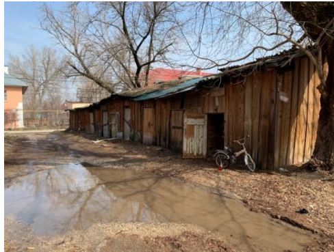
Рисунок В.4 – Деревянный сарай, построенный в 1950-х годах
