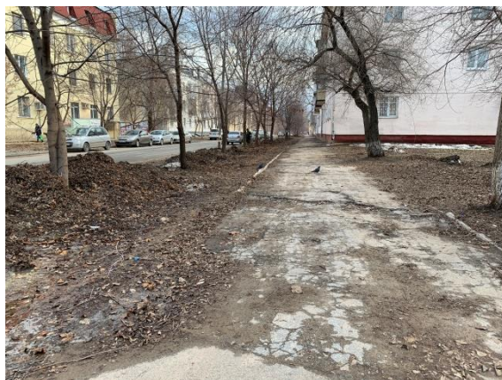
Рисунок А.15 – Плохое качество дорожного покрытия тротуара
