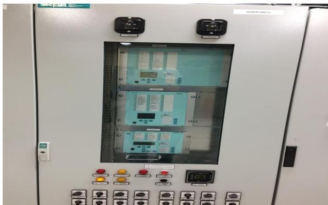
Рисунок 9 – Шкаф защиты 110кВ ШЗТ-МТ-051-152
