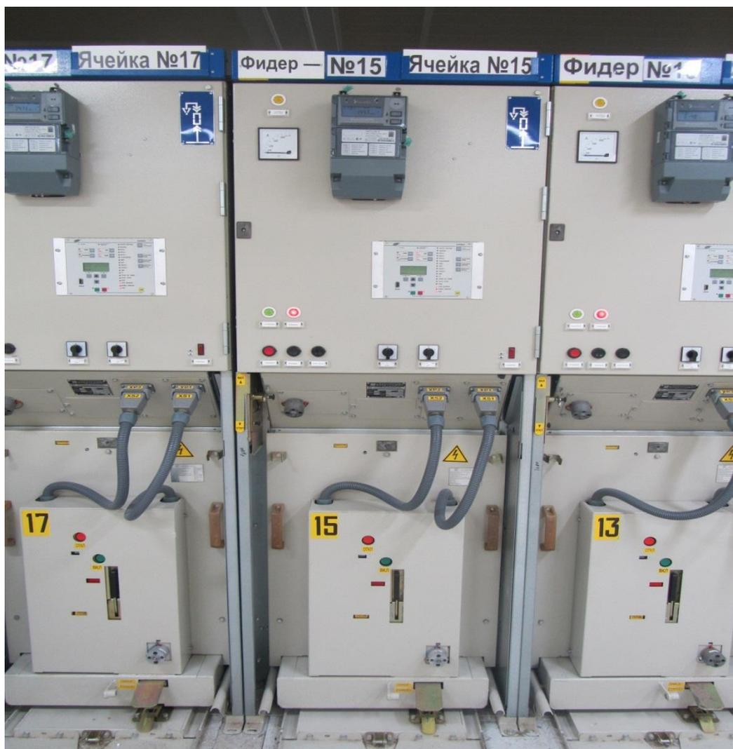
Рисунок 12 – Микропроцессорные терминалы БЭ2502А в ячейках КРУ 10кВ
