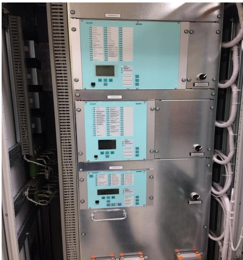
Рисунок 10 – Микропроцессорные терминалы в ШЗТ-МТ-051-152
