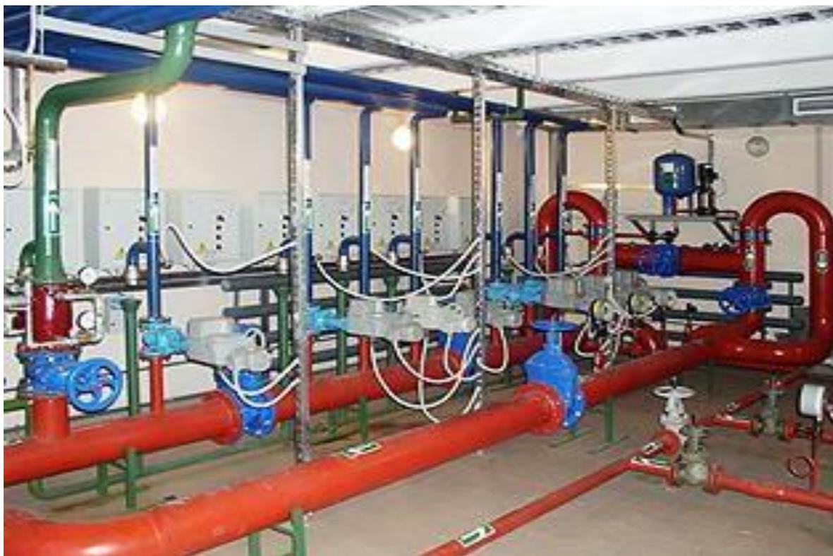
Рисунок 6 – Установка пенной системы пожаротушения
