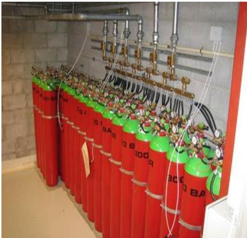
Рисунок 7 – Установка газовой системы пожаротушения
