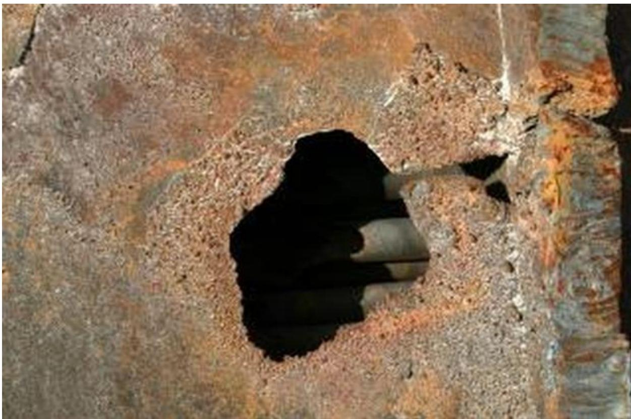
Рисунок 16 – Стальной резервуар, пораженный коррозией
