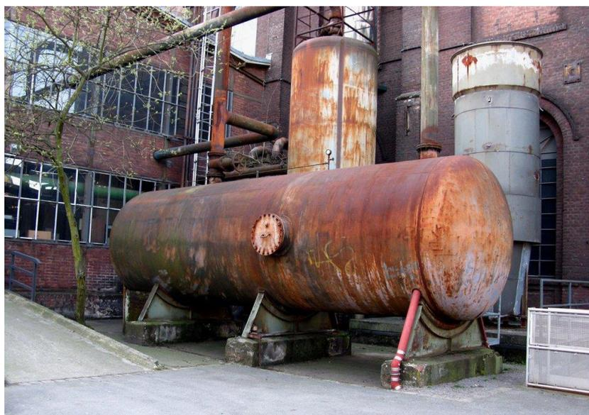
Рисунок 9 – Атмосферная коррозия металла
