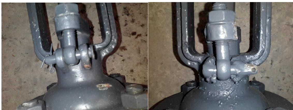
Рисунок 23 – Болты крепления нажимной планки задвижки
