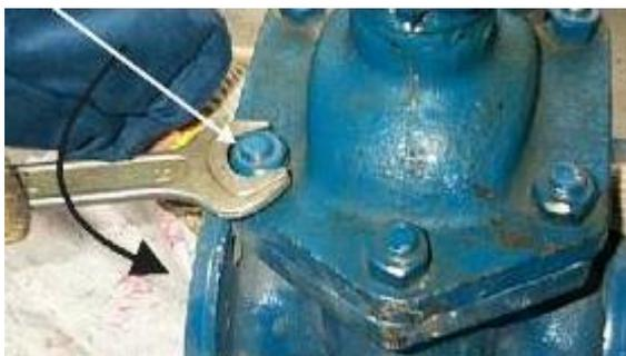
Рисунок 67 – Откручивание гаек крышки задвижки
