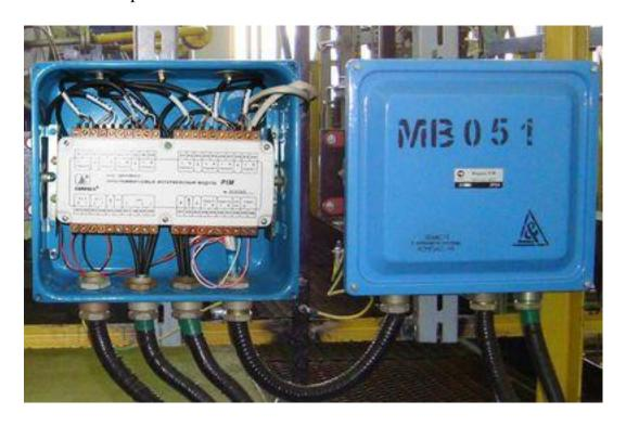
Рисунок 9 — Размещение программного интерфейсного модуля в защитной коробке
