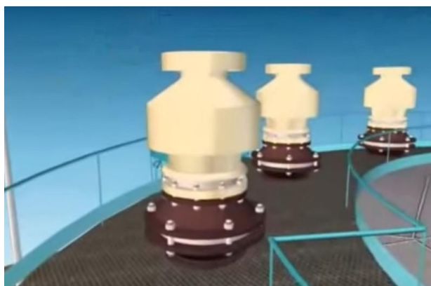
Рисунок 1.7 - Дыхательные клапаны
