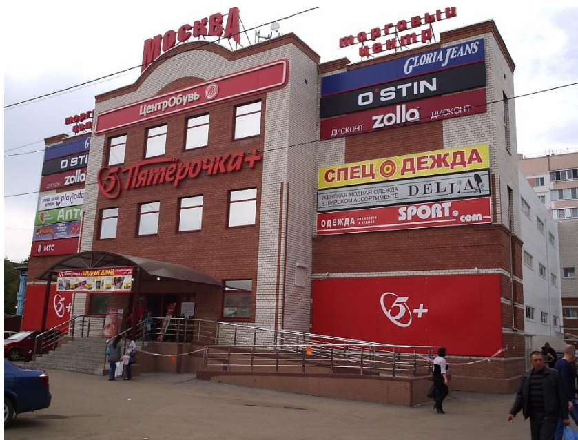
Рисунок 1.1 - Главный фасад здания (ул. Московская)
