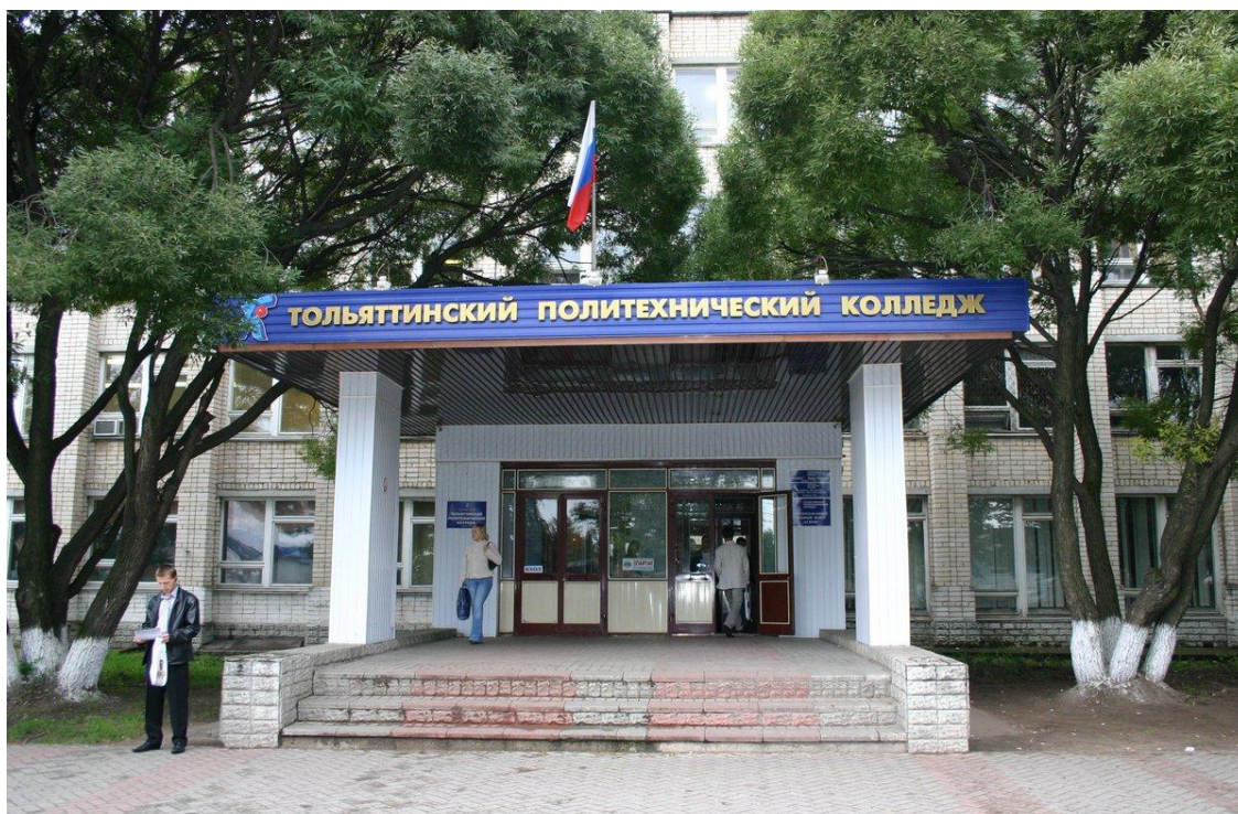
Рисунок 1 – Главный вход в здание колледжа
