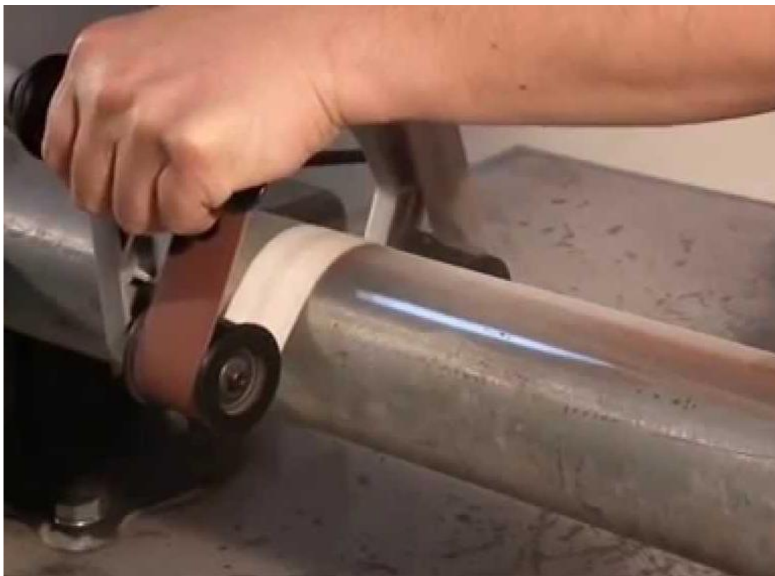
Рисунок 2.10 – Шлифовка поверхности муфты
