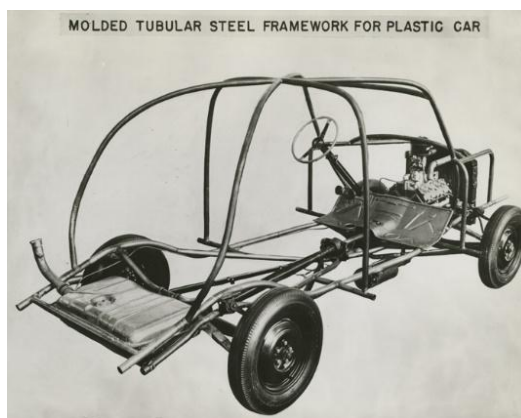
Рисунок 3 - Трубчатая рама Soybeancar [16]
