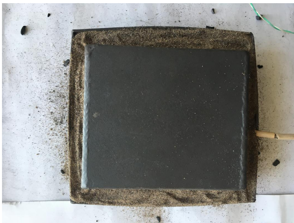
Рисунок 2.10 – Укладка третьего слоя
