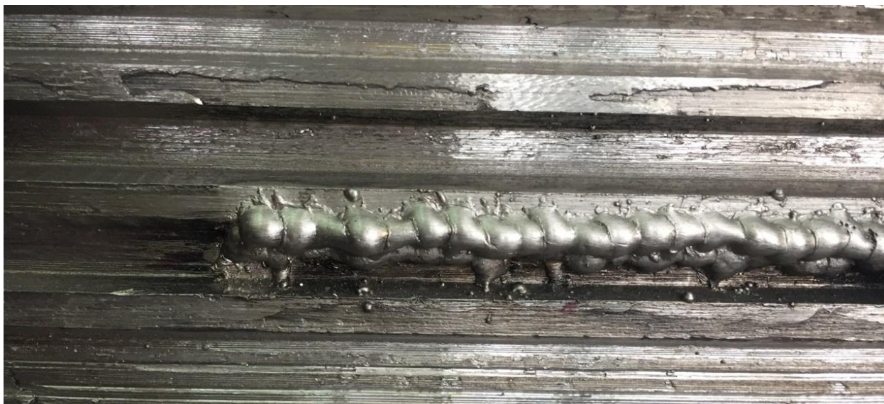
Рисунок 52 – Исправление дефектов сварного шва
