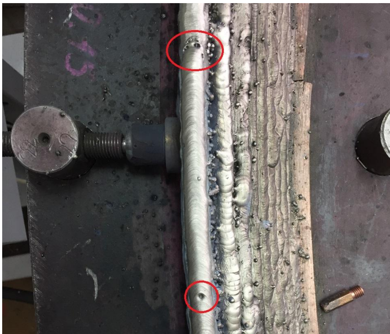
Рисунок 50 - Поры в сварном шве
