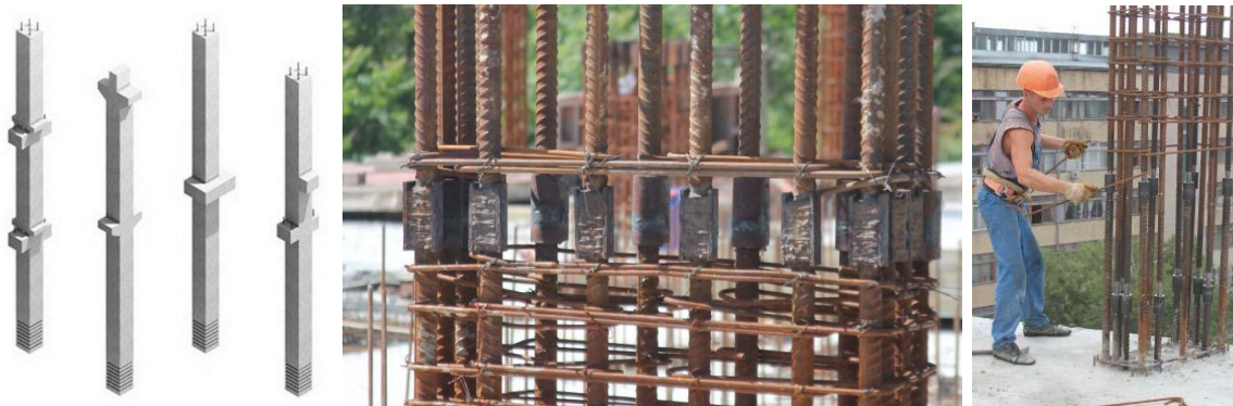
Рисунок 1.2 – Железобетонные колонны и соединение их элементов
