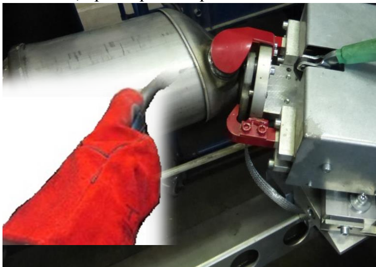
Рисунок 2.16 - Приварка конуса в сборе к корпусу нейтрализатора
