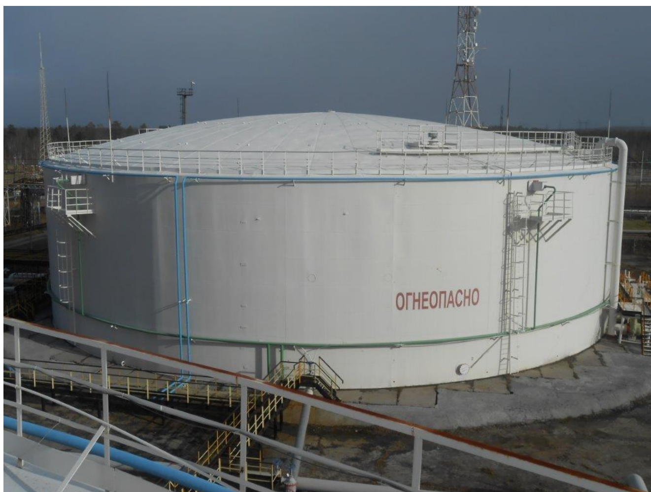
Рисунок 1.1 – Общий вид резервуара.
