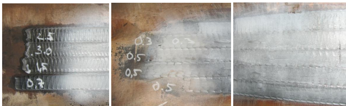
Рис. 1.7 - Стrojка стресс-коррозионных дефектов при различной глубине выборки для проверки остаточных дефектов трубы 1420x18,7мм К60, демонтированной из шлейфа КС
