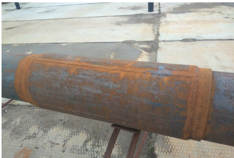
Рисунок 1.2 - Герметичная сварная стальная муфта конструкции №3
