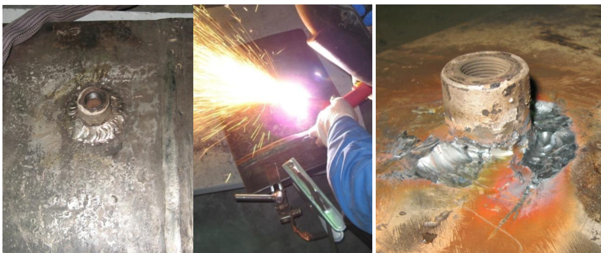
Рисунок 1.6 - Стrojка ручным плазмотроном углового сварного шва врезки бобышки диаметром 22мм
