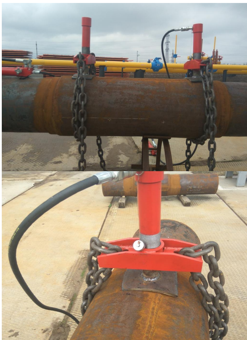
Рисунок 2.15 - Обжатие муфты гидравлическим домкратом
