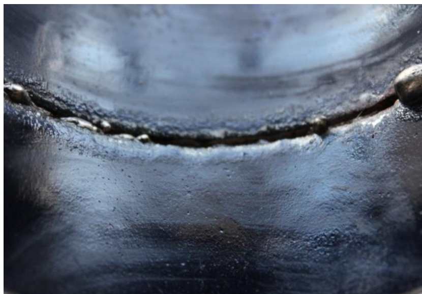
Рисунок 2.9 – Образец сварного соединения трубы с силикатно-эмалевым покрытием без образования обратного валика
