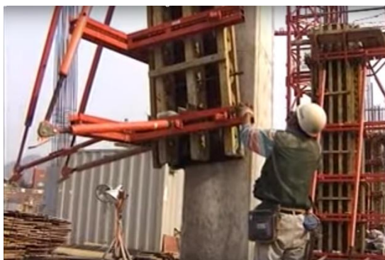
Рисунок 3.11 – Распалубка колонн
