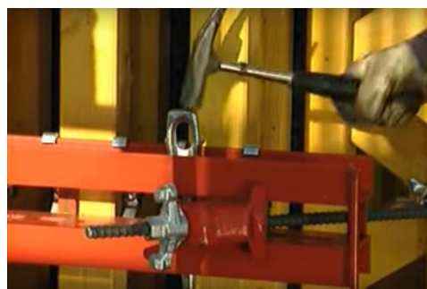
Рисунок 3.7 – Соединение металлических ригелей тяжем
