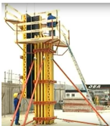
Рисунок 3.10 – Демонтаж опалубки
