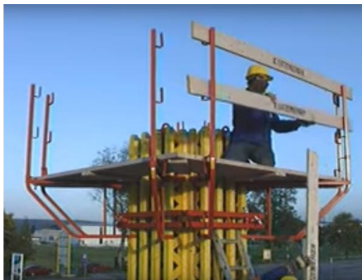
Рисунок 3.9 – Устройство консольных подмостей
