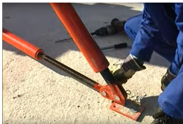
Рисунок 3.8 – Крепление подкосов
