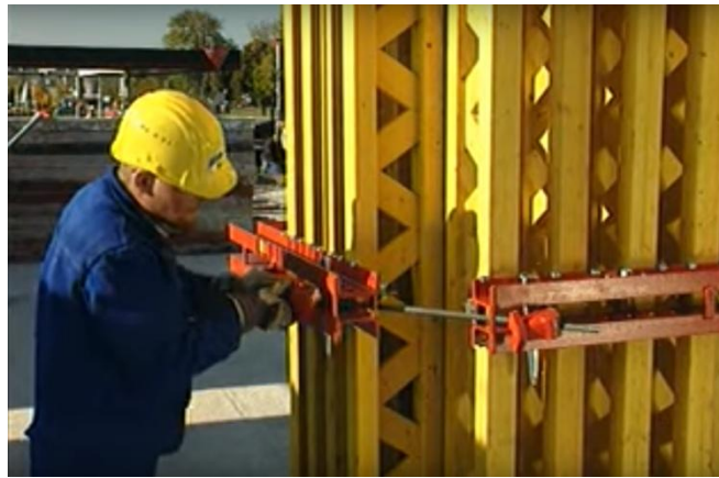
Рисунок 3.6 – Соединение частей опалубки тяжем
