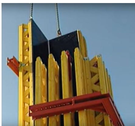
Рисунок 3.5 – Строповка опалубки
