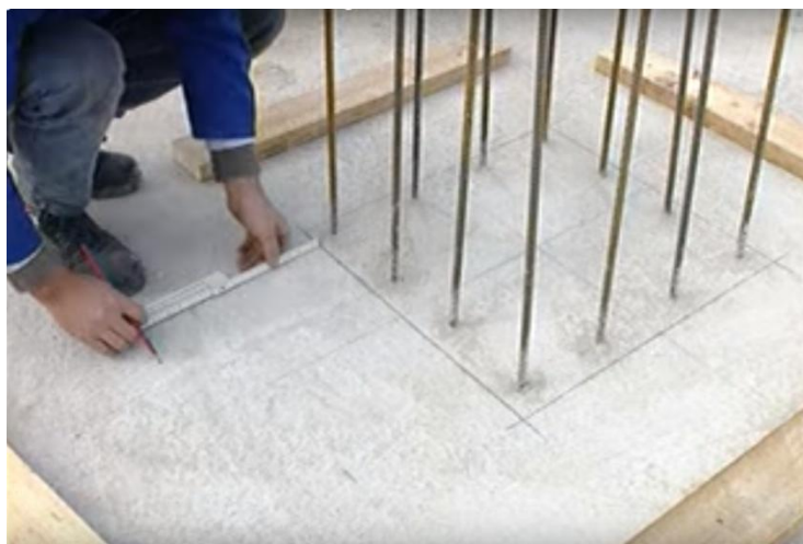
Рисунок 3.4 – Нанесение разметки у основания колонны
