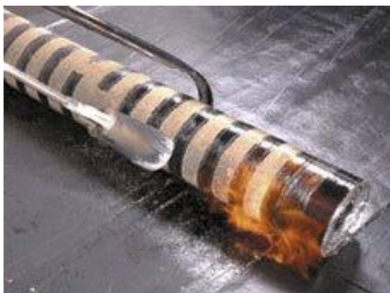
Рисунок 3.1 – Разогрев кровельного рулона
