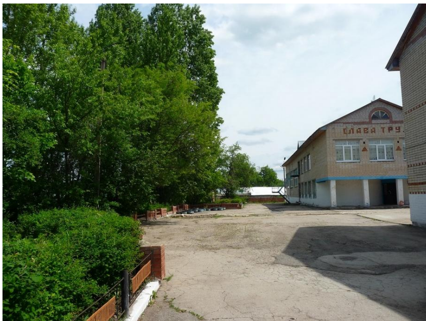
Рисунок 3.22 – Вид со входа на площадку для торжественных мероприятий
