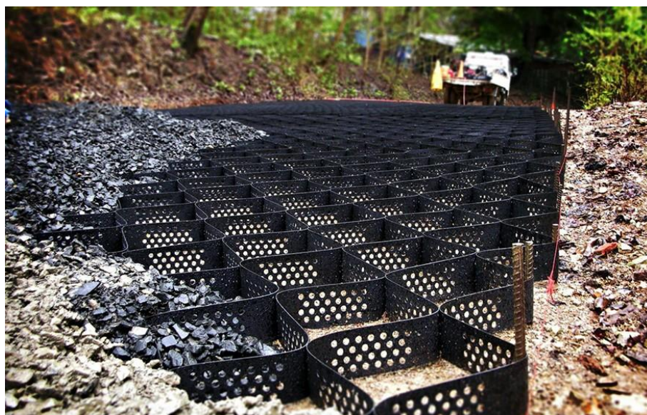
Рисунок 2.8– Георешетка в основании гравийной дорожки
