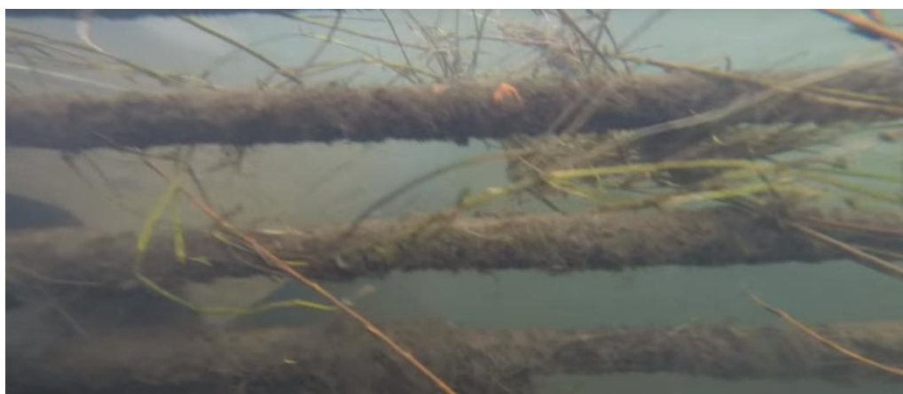
Рисунок 2.6 – Кадры водолазного видеообследования оголовков на ТЭЦ-2 в г. Уфа
