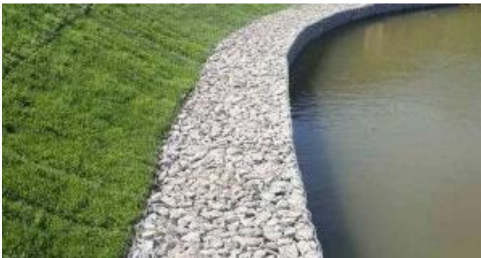
Рисунок 3.6 – Укрепление береговой линии габионами
