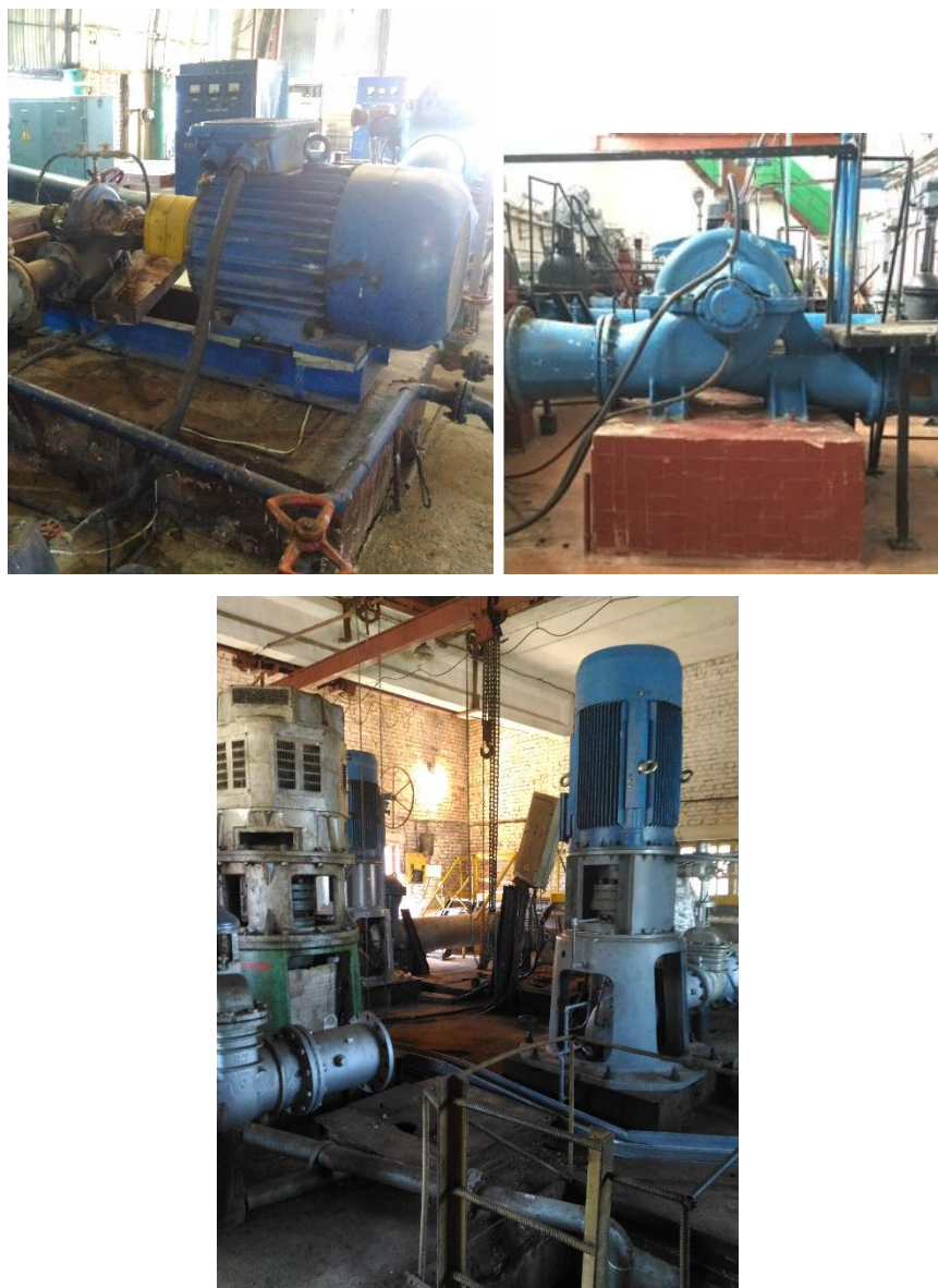
Рисунок 2.9 – Насосы разных типов на насосной станции первого подъема, находящейся в длительной эксплуатации (п. Гранный, Самарской области)
