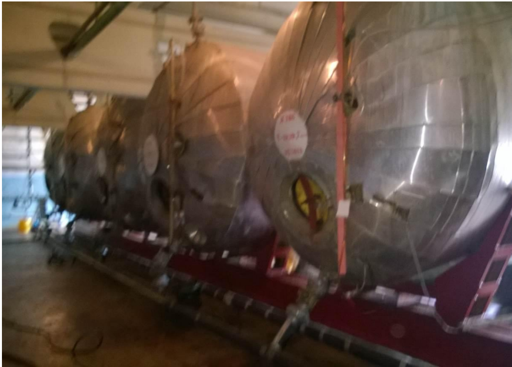
Рисунок А.1 – Технологические емкости объемом 20,0 м 3 на отм. +4.200
