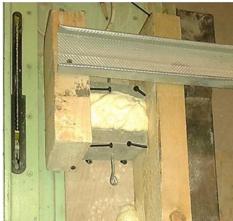
Рисунок 28 –Соединение двух бетонных шляпок посредством пенополиуретана
