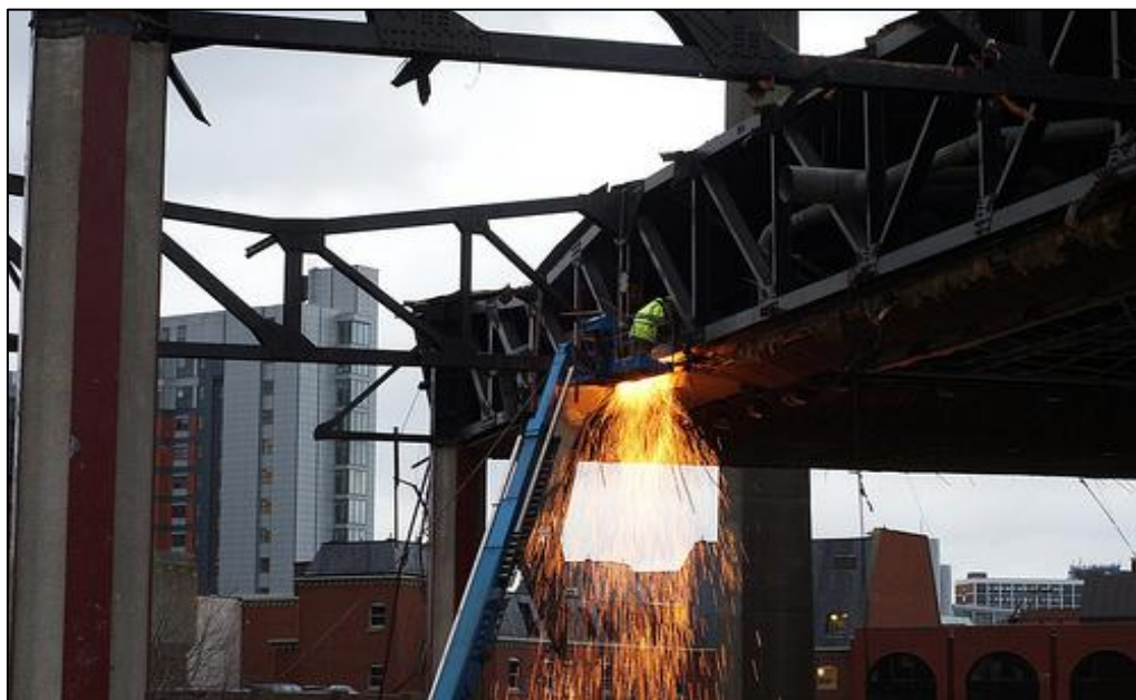
Рисунок 20 – Производство сварочных работ при усилении стальной фермы
