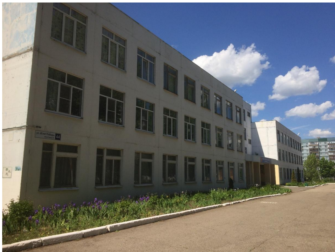
Рисунок А.1—Фото здания начальной школы
