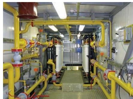
Рисунок 12 – Мембранная газоразделительная установка МГБ-2.5-95.0-1500
