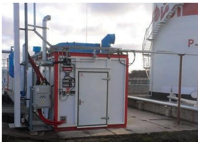
Рисунок 14 – Промышленная мембранная газоразделительная установка для ООО «ЛУКОЙЛ-Калининградморнефть»
