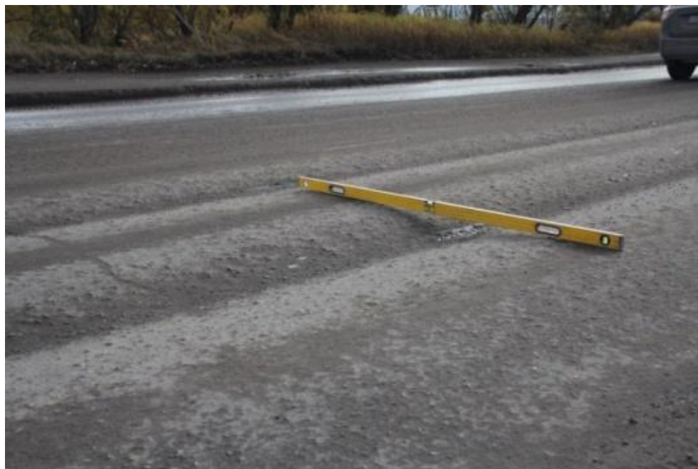
Рисунок 3 – Длинные волны на дорожном покрытии
