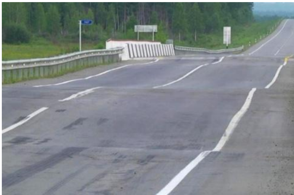
Рисунок 2 – Короткие волны на дорожном покрытии
