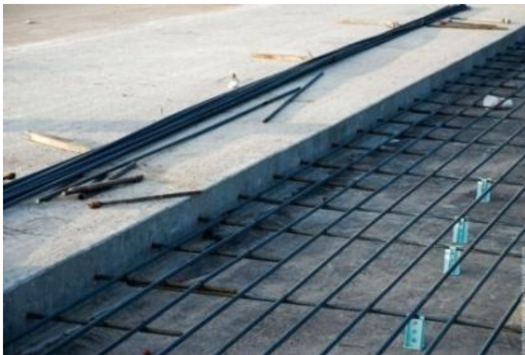
Рисунок 13 – Применение арматуры при строительстве дорог
