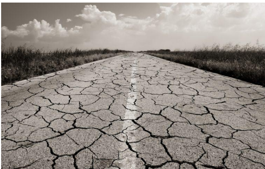
Рисунок 6 – Растрескивание поверхности
