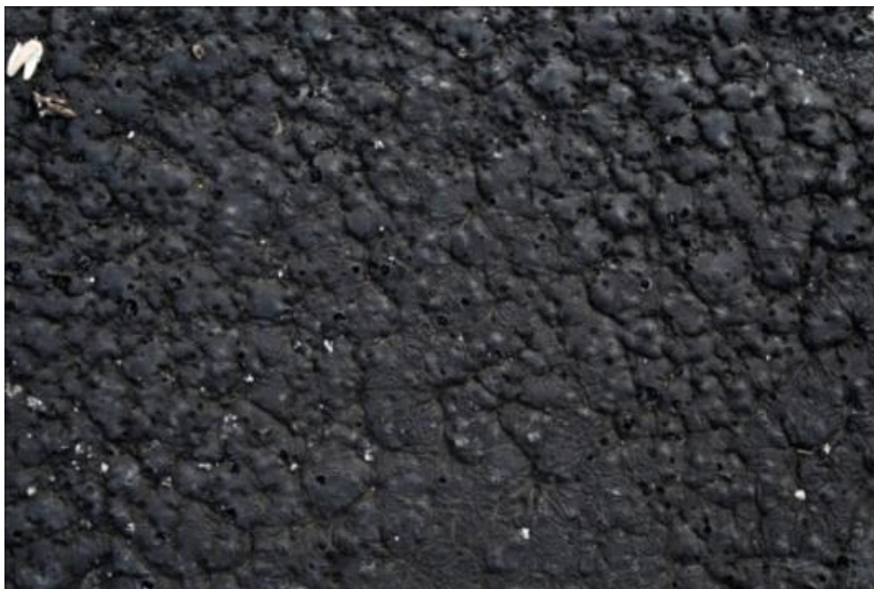
Рисунок 5 – Неравномерная текстура поверхности
