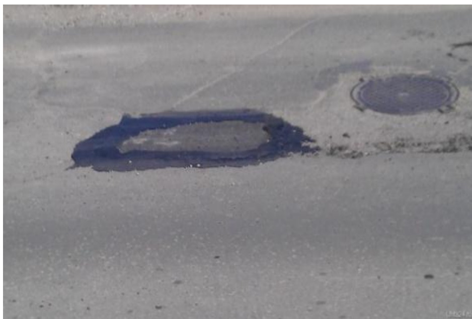
Рисунок 7 – Битумные пятна на асфальте
