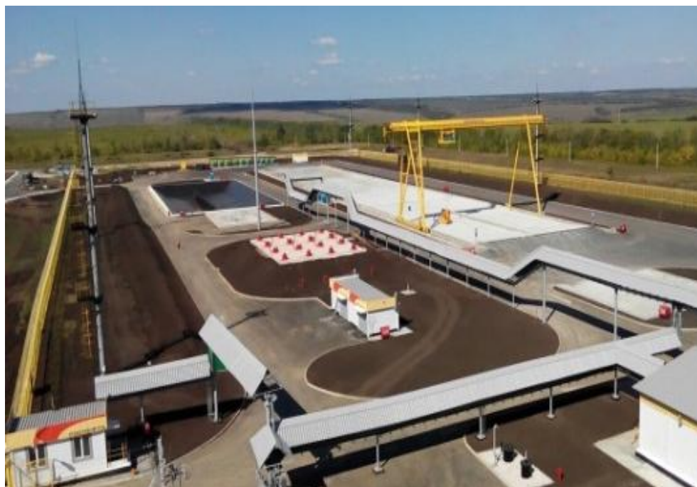
Рисунок 16 - Площадка переработки замазученных грунтов на Горбатовском
