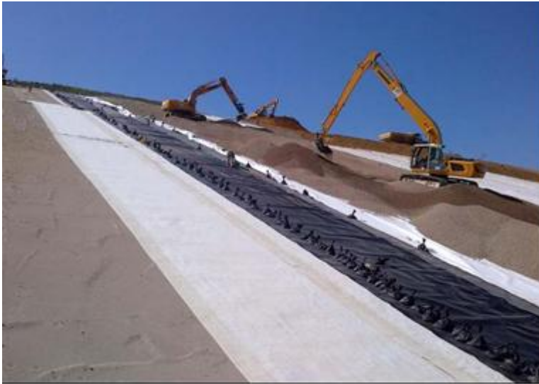
Рисунок 20 - Создание защитного геомембранного слоя на полигоне ТБО
