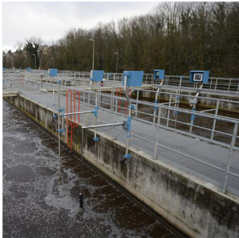
Рисунок 25 - Вариант закрепления датчика в аэротенке
