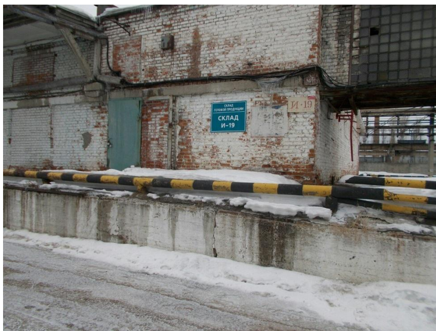
Рисунок 1.2 - Вид на фасад здание склада И-19
