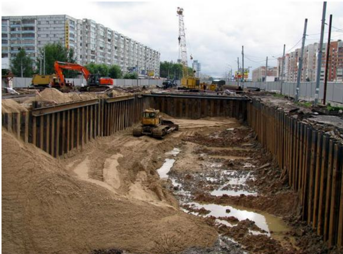
Рисунок 11 – Котлован, оборудованный шпунтовыми сваями
