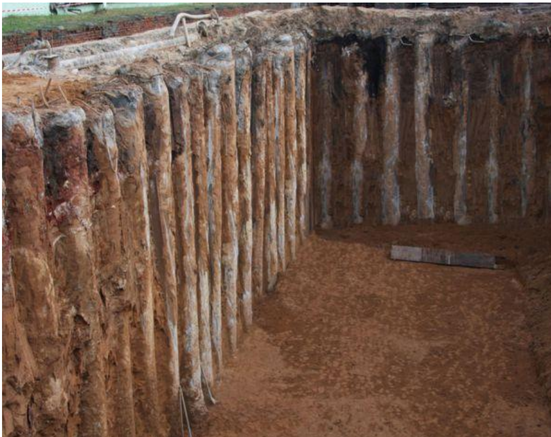
Рисунок 13 – Защитное ограждение, оборудованное из бурящих свай
