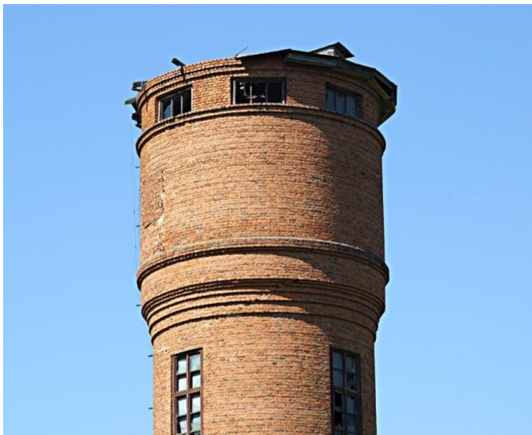
Рисунок 8 – Приемный бак водонапорной башни На рисунке 9 изображена водонапорная башня.
