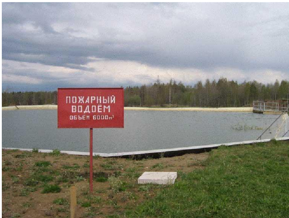
Рисунок 6 – Искусственный пожарный водоем
