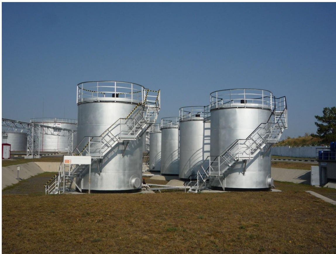
Рисунок 11 – Резервуарный парк масел
