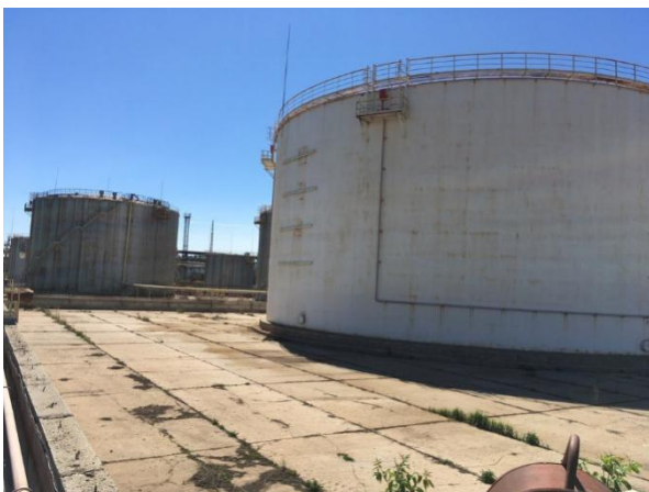
Рисунок 1.3– Вид на резервуарный парк с северной стороны
