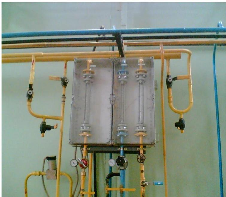
Рисунок 3.1.8 – Блок ротаметров
