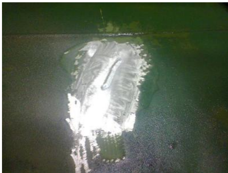
Рисунок 1.2 – Заварка трещины на корпусе цистерны для перевозки битума
