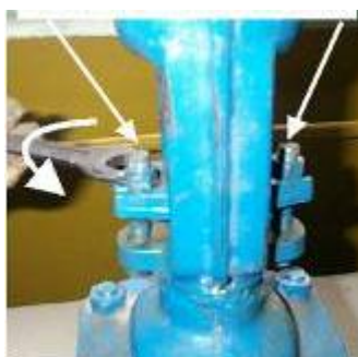
Рисунок 3.1 – Откручивание гаек нажимной планки
