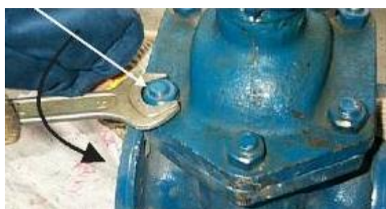
Рисунок 3.4 – Откручивание гаек крышки
