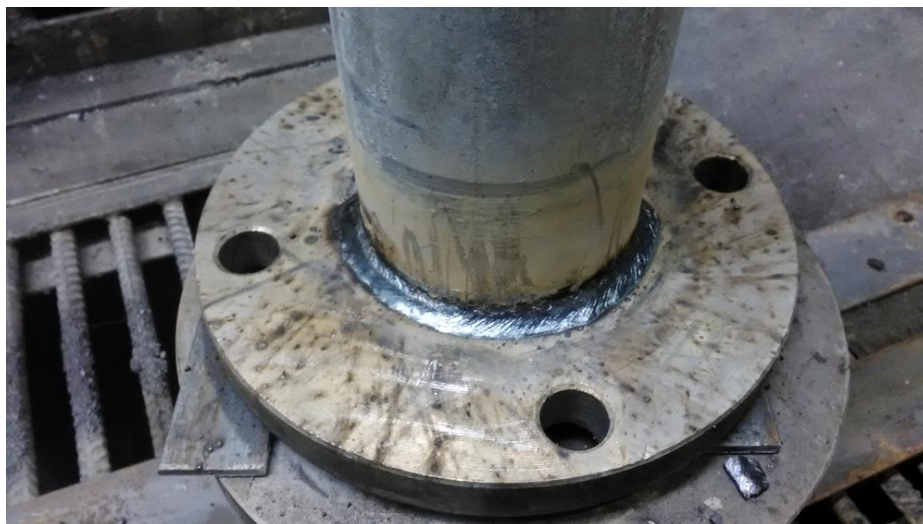
Рисунок 15 – Сварка фланца с трубой
