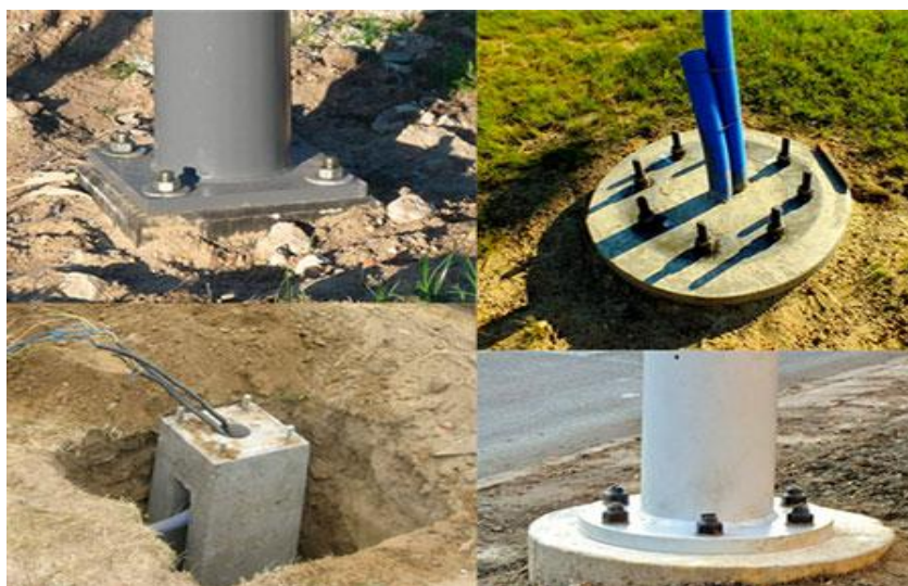
Рисунок 4. – Фундамент под металлическую основу
