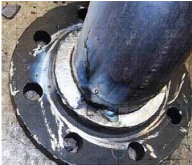
Рисунок 3. – Сварка фланца к трубе
