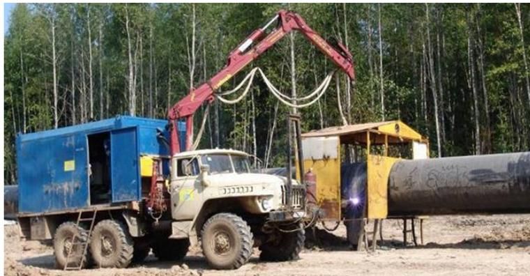
Рисунок 2.5 – Сварочный агрегат
