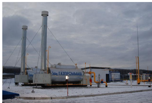
Рисунок 1.1 – Подключение газораспределительной станции к магистральному газопроводу
