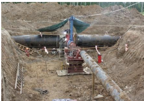
Рисунок 1.1 – Подключение газораспределительной станции к магистральному газопроводу
