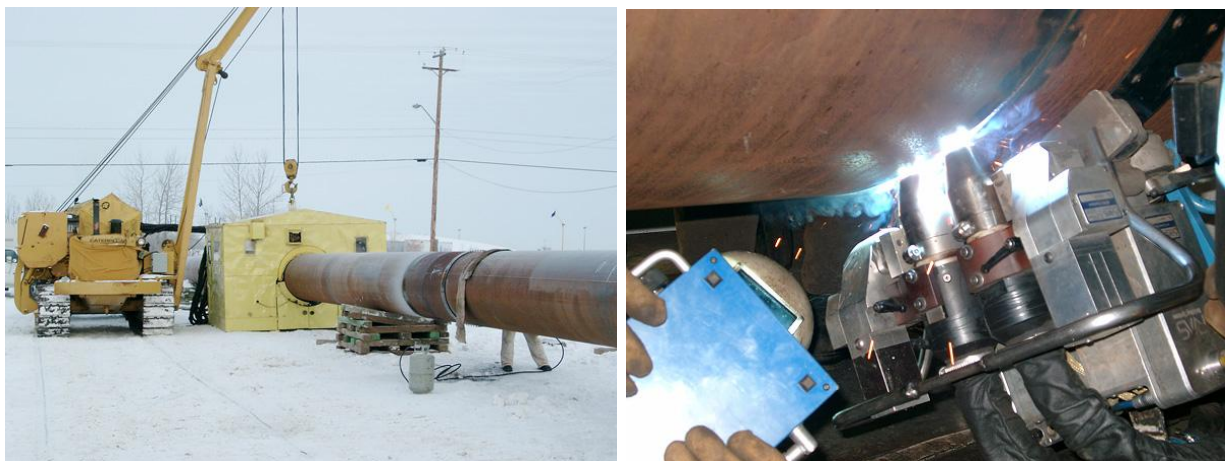
Рисунок 2.14 – Применение технологии TimeTwin в сфере строительства трубопроводов
