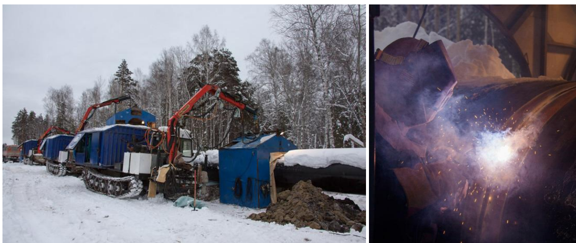
Рисунок 1.2 – Ремонтная сварка нефтепровода «Нижневартовск-Курган-Куйбышев»
