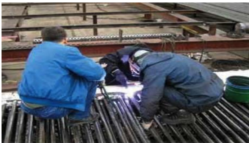
Рисунок 1.4 - Монтажные сварочные работы
