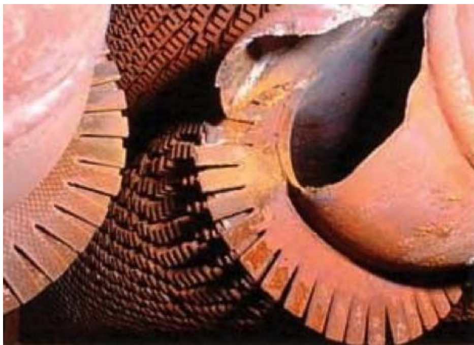
Рисунок 1.3 - Разрушение коллектора из-за ползучести металла после воздействия высоких температур
