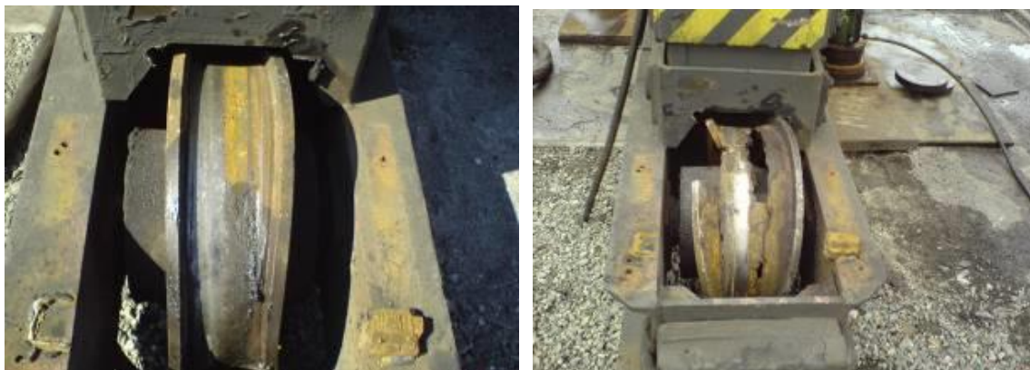
Рисунок 1.1 - Виды износа ходовых колес портального крана: а - отслоение поверхности катания, деформация реборды; б - разрушение колеса
