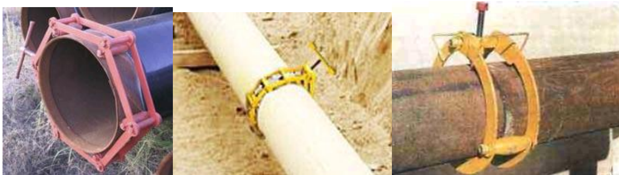
Рисунок 1.4 – Сварка с применением центратора ЦЗН
